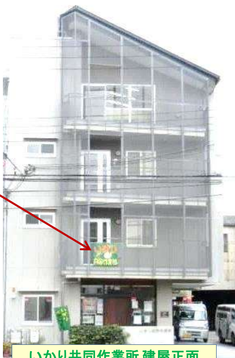
いかり共同作業所 建屋正面
